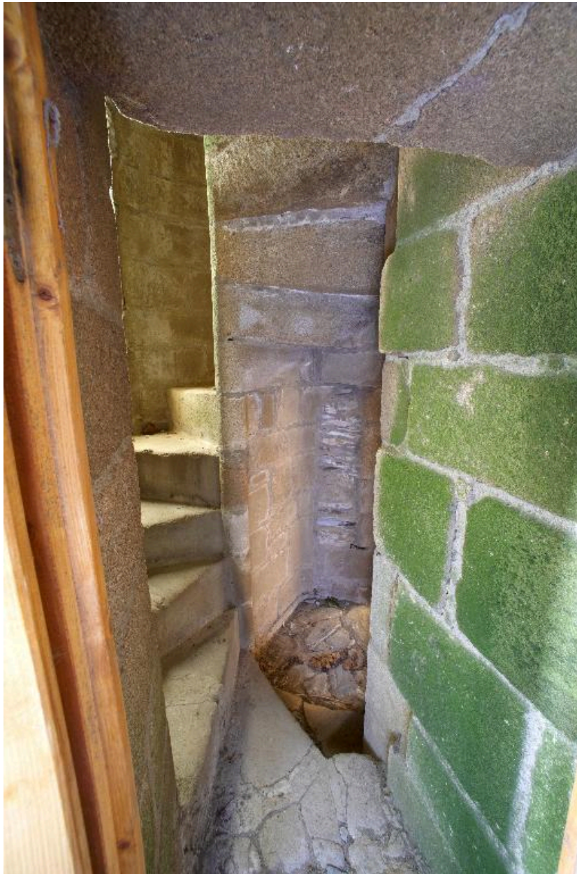
Tour sud-ouest, passage vers le 2e escalier en vis.
