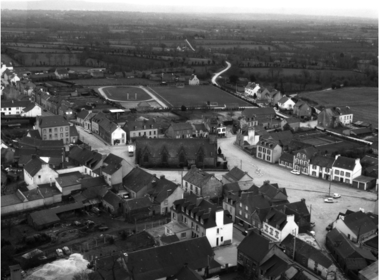
Plonévez-du-Faou, église paroissiale Saint-Pierre : vue de l'église, prise du sud, état en 1973
