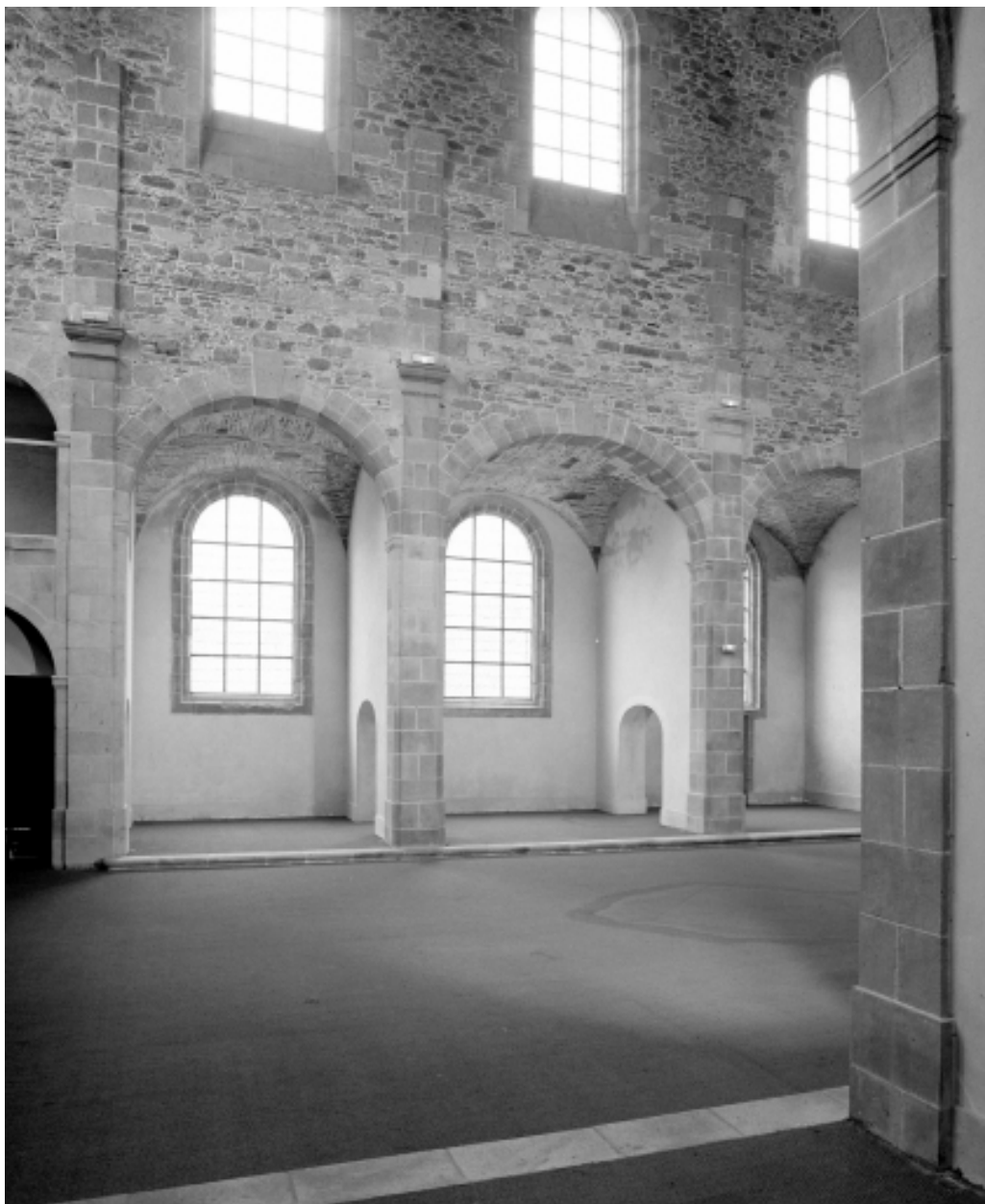
Intérieur, bras Ouest du transept : vue générale
