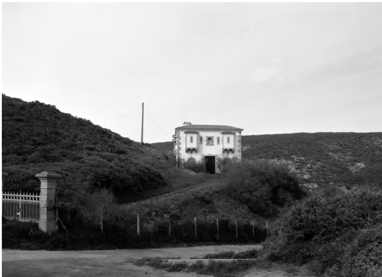
Corps de garde, vue générale
