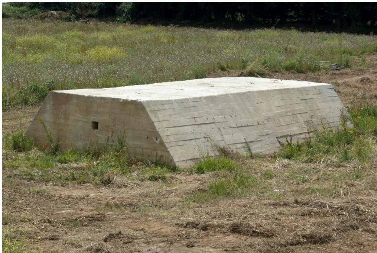
Bunker de type tôle métro (Heinrich Wellblech)
