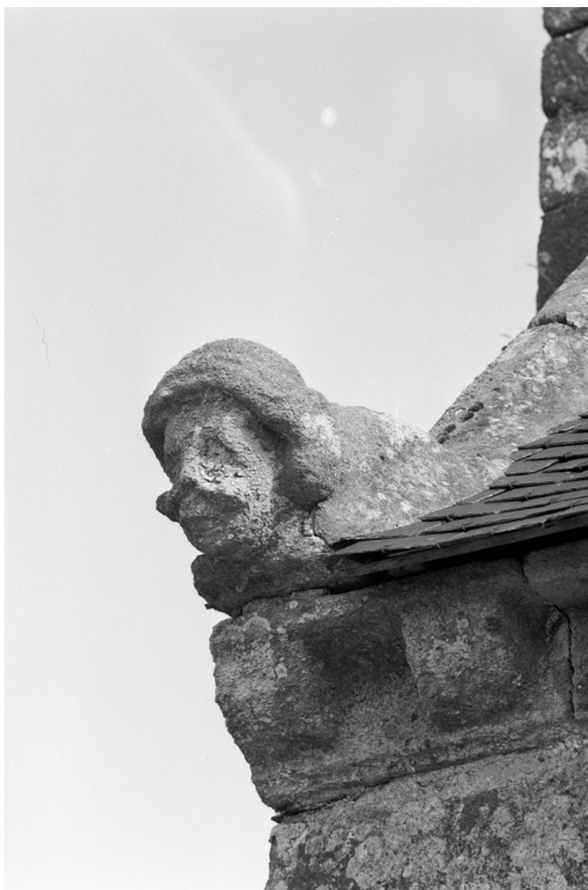
Nef, façade sud : détail du corbeau inférieur de la chevronnière ouest et de la corniche à modillons
