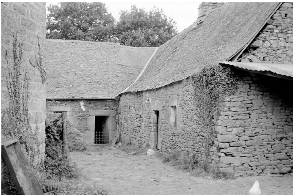
Péro, ferme du 17e siècle : élévation postérieure (état en 1969)
