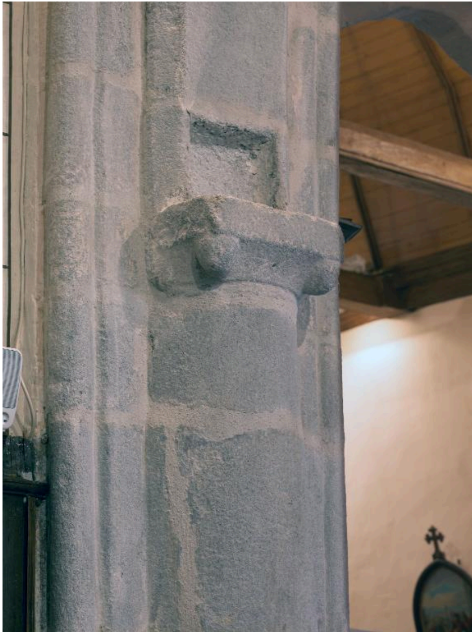
Emplacement possible de la poutre de gloire
