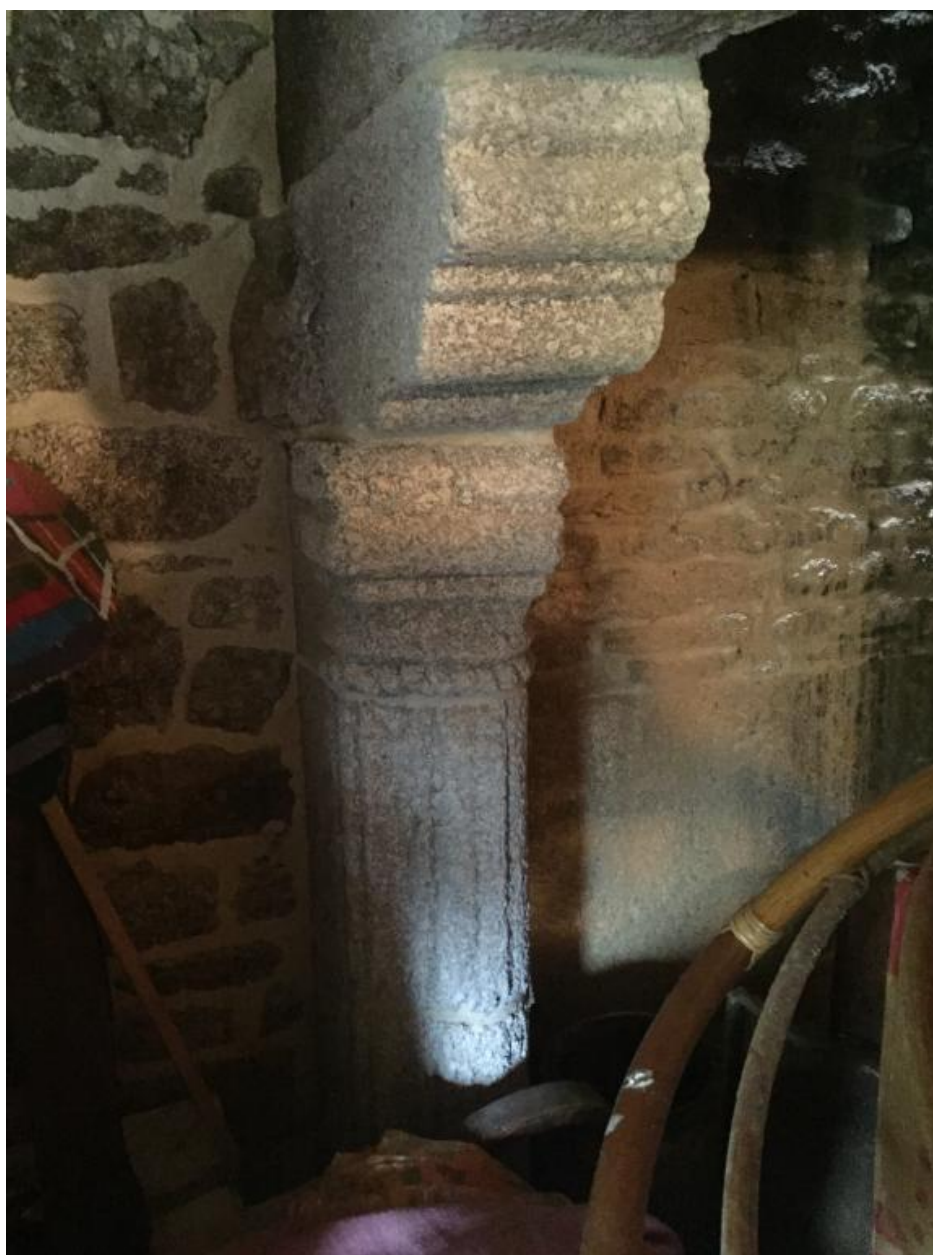
Détail d'une cheminée
