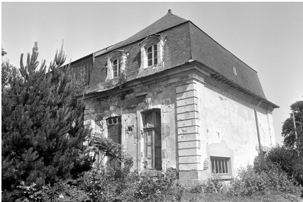
Façade sud ; pavillon est
