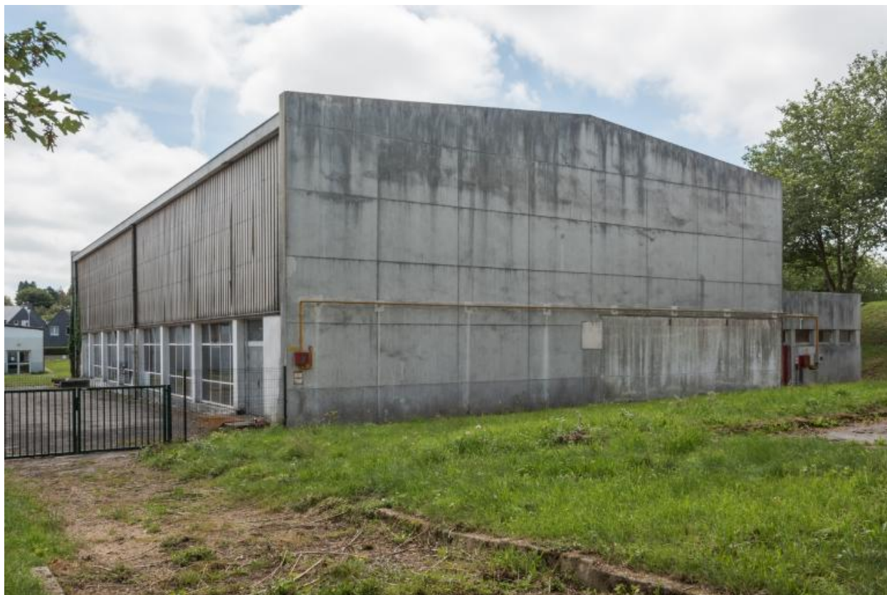
Vue d'ensemble prise du nord-est (H. Péron et A. Weisbein, architectes, 1968).
