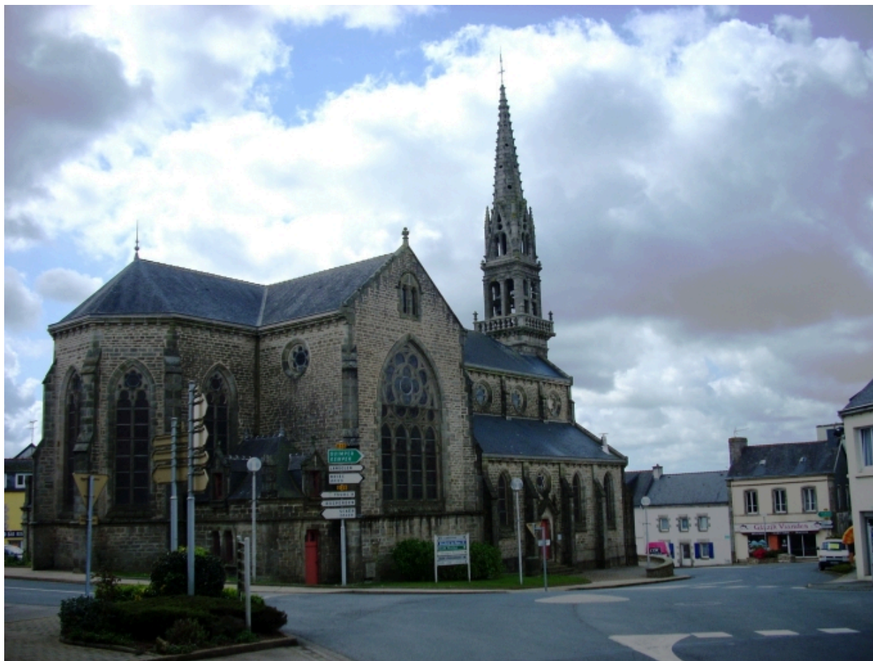
Coray, église paroissiale Saint-Pierre et Saint-Paul : vue générale nord-est
