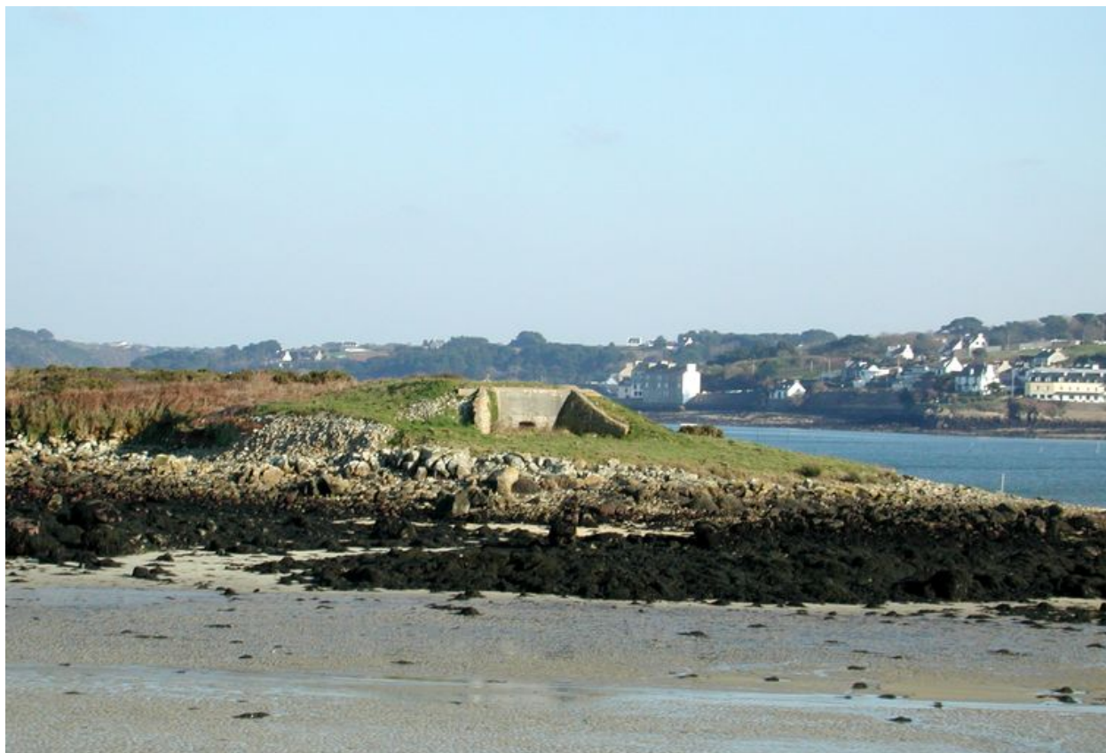
Vue de l'île depuis la terre : extrémité ouest (état en 2003)
