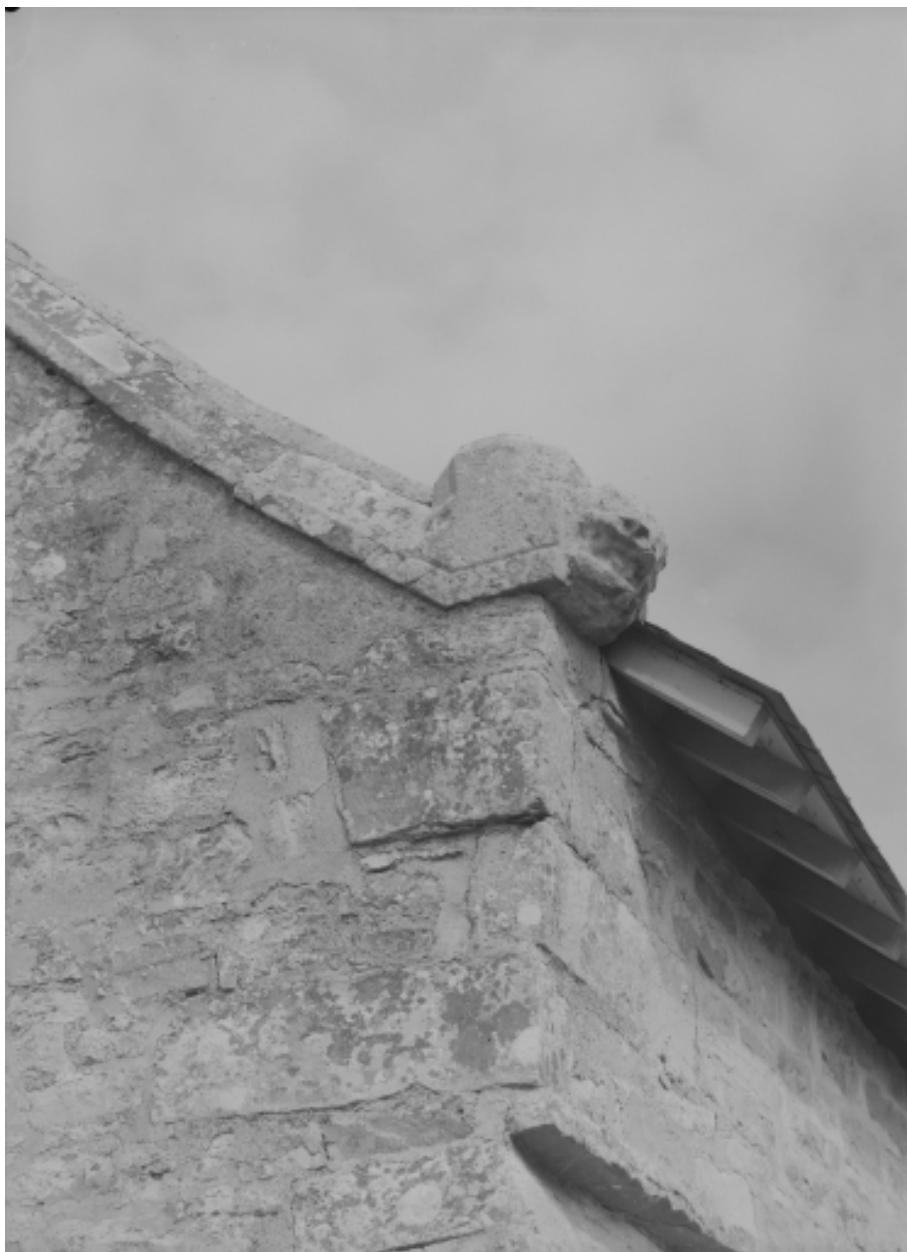
Elévation ouest : détail de la pierre d'assise sSud
