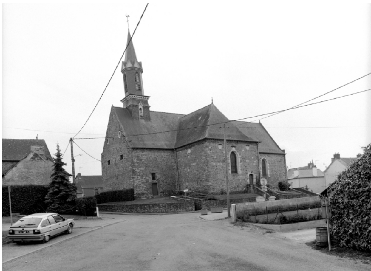
Elévation Nord-Est : vue générale
