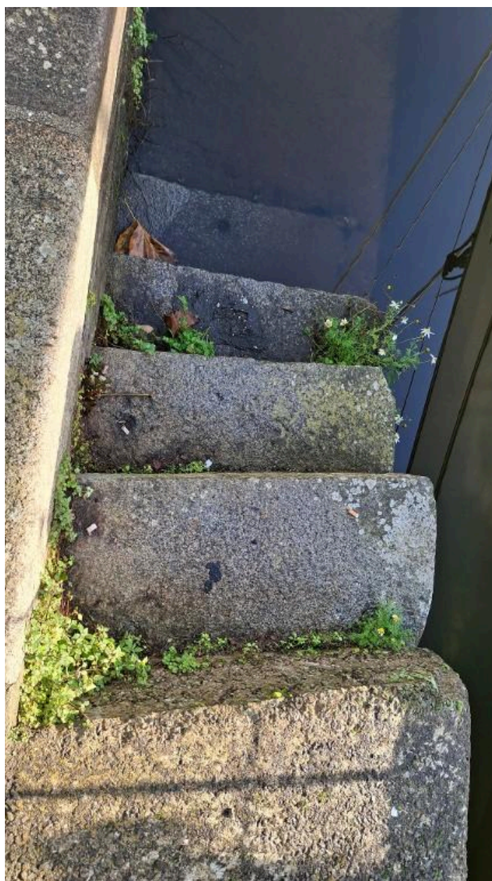
Escaliers du quai situé rue Adolphe Le Bail
