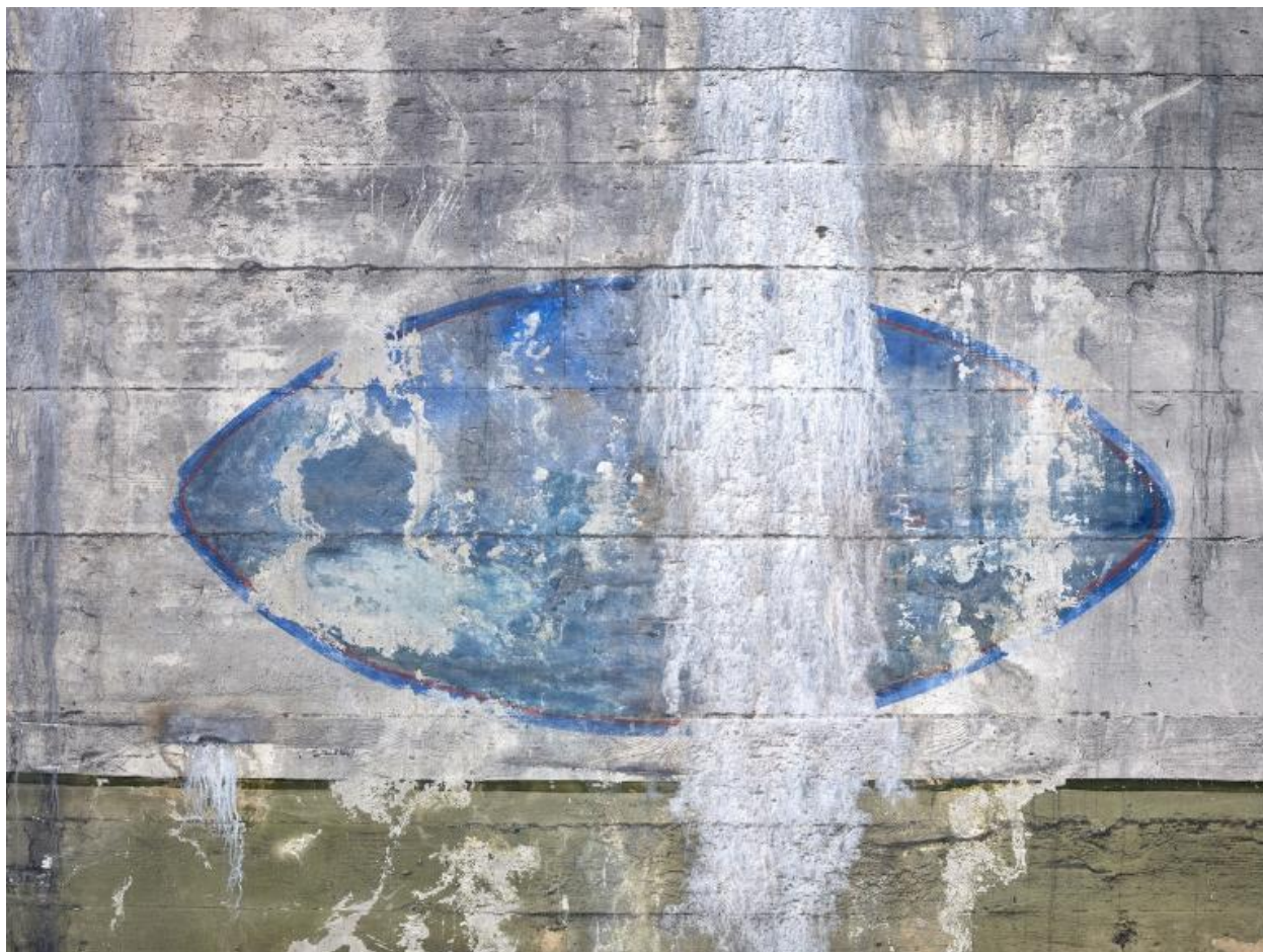
Vue du deuxième étage de l'extension sud : salle de pause, peinture murale d'origine allemande. Le cartouche de couleur bleu est à demi effacé
