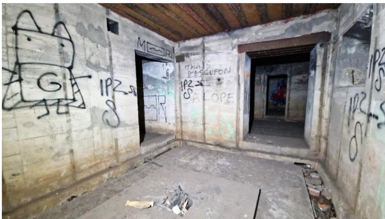
Vue intérieure : salle de commandement. Les murs sont couverts de graffitis
