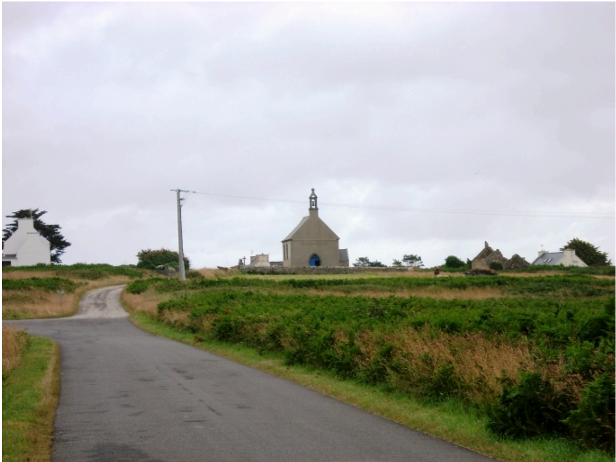
Ouessant, chapelle de Ker Ber : vue de situation depuis l'ouest
