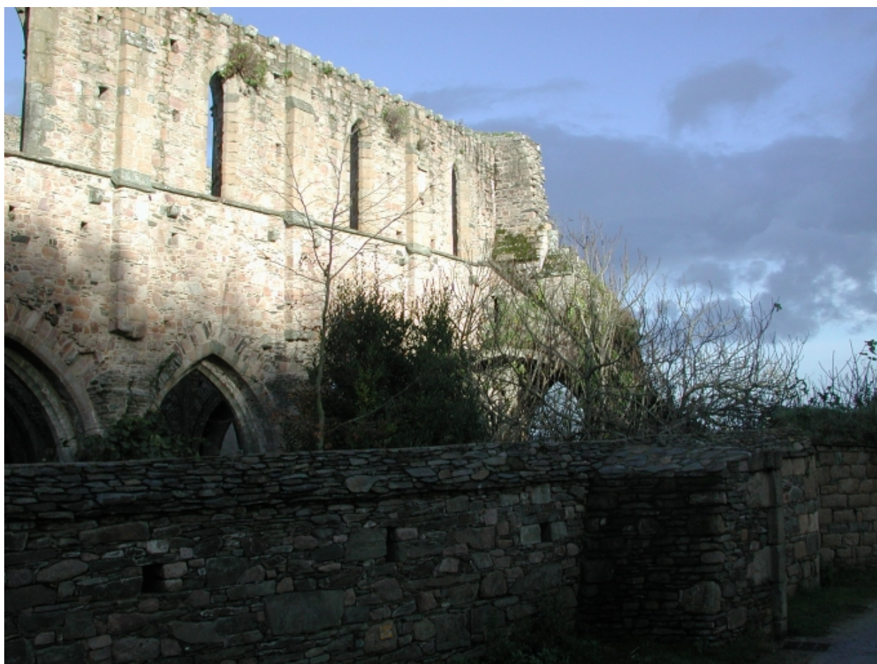
Vue du mur d'enceinte Nord, restauré autour de l'église
