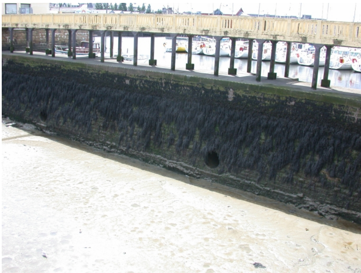
Vue du mur-digue du déversoir de superficie
