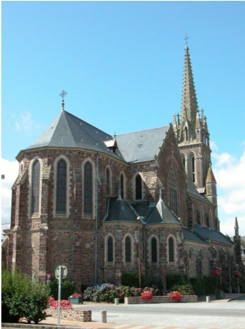
Vue générale est
