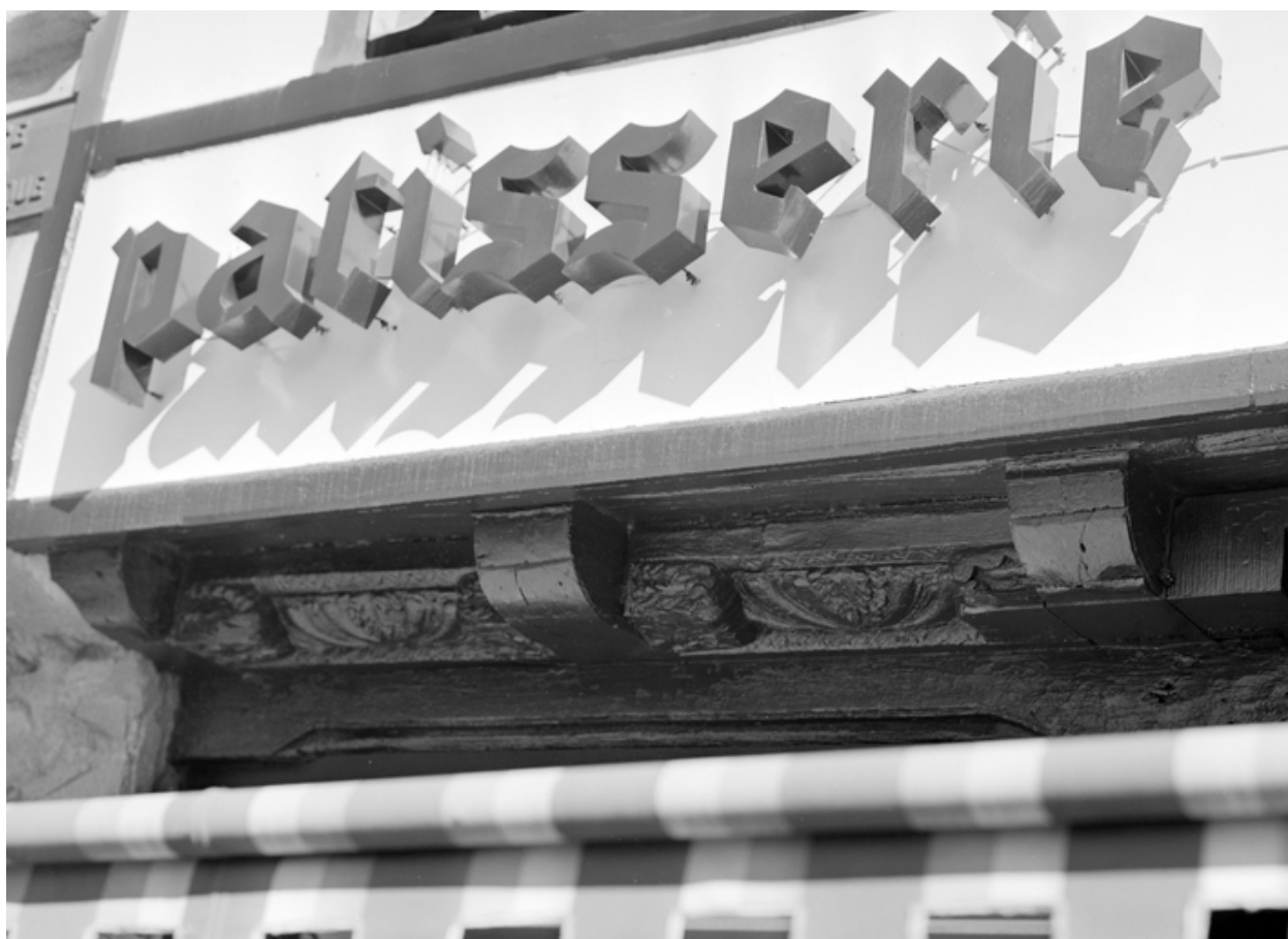
Elévation antérieure : encorbellement du 1er niveau avec entretoises à godrons
