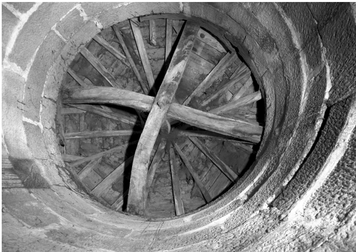
Charpente de la tourelle et fin de l'escalier à vis vus du premier étage
