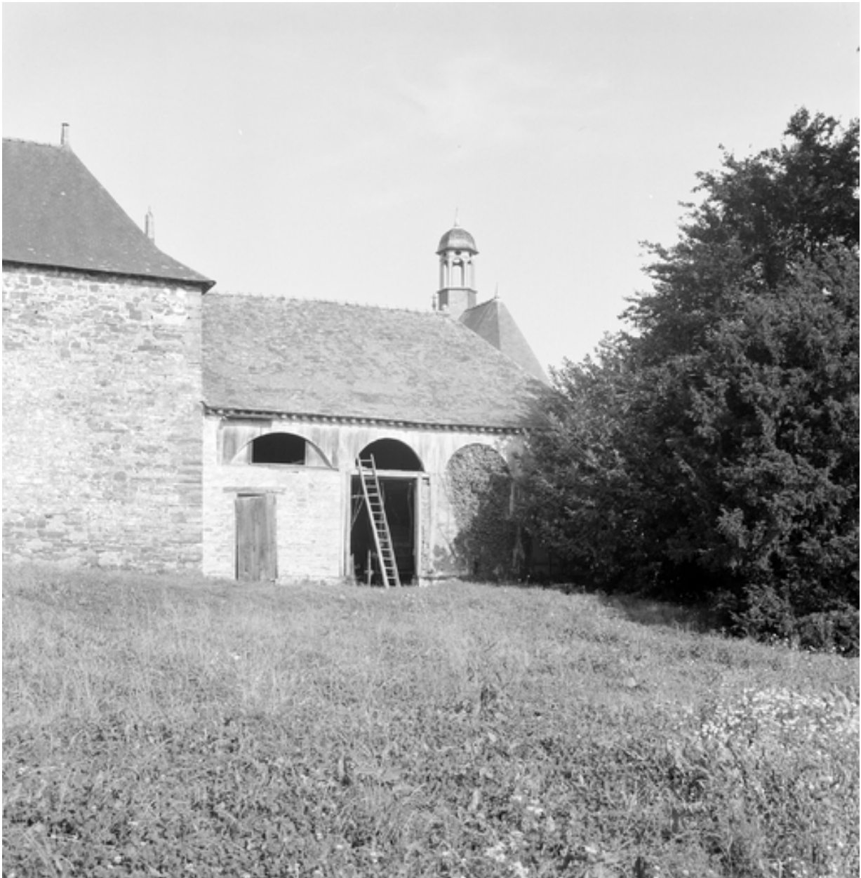
Dépendances, pressoir, face sud, vue générale.
