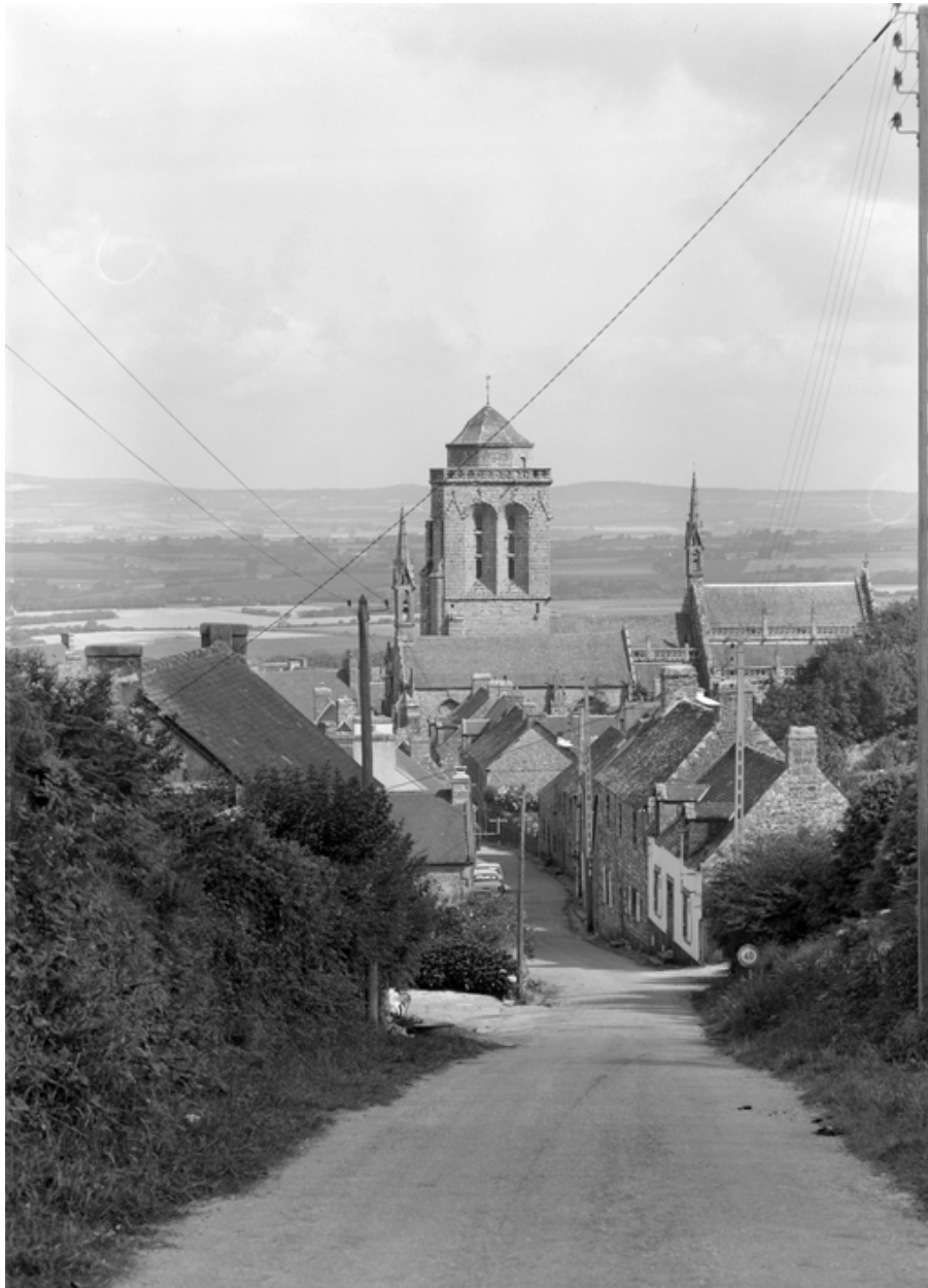
Vue de situation prise du sud
