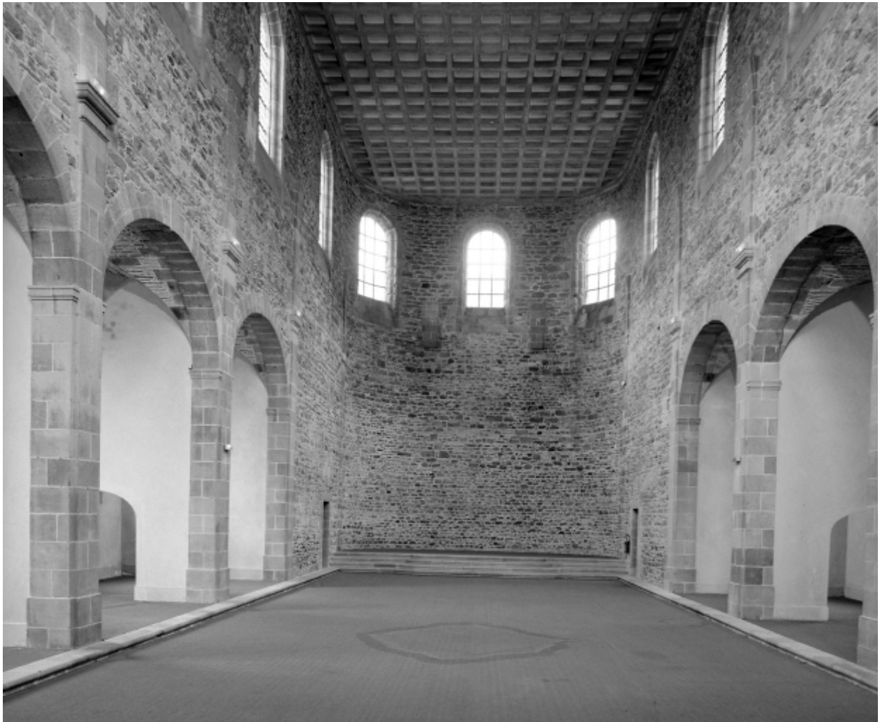
Intérieur : vue générale vers le chœur
