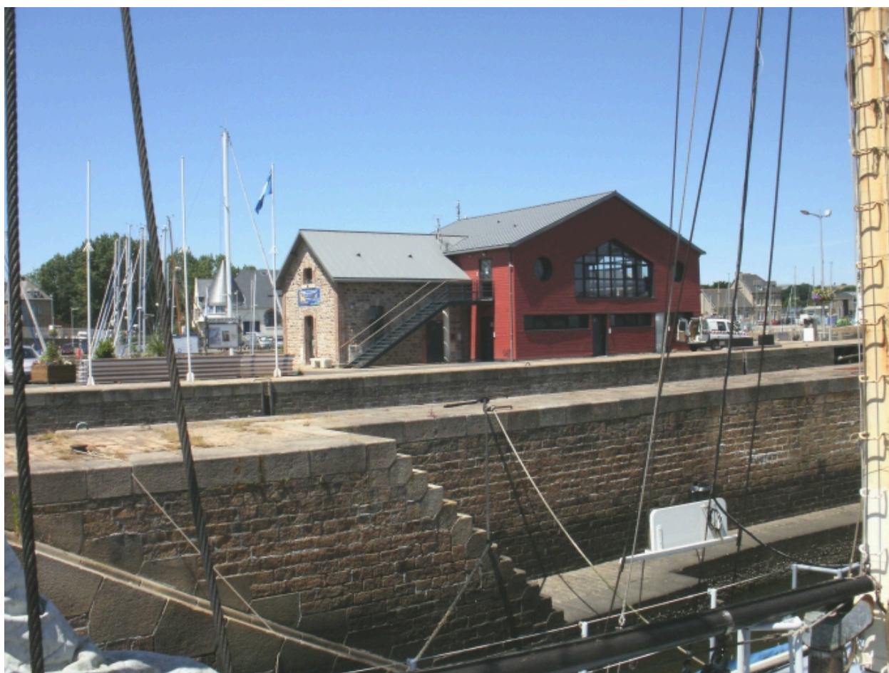
Vue de la façade Est de l'ancien bâtiment, associé à l'aménagement contemporain, devant l'écluse
