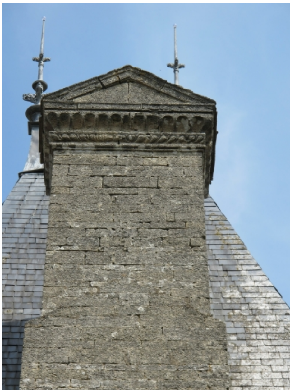
Souche de cheminée en calcaire des faluns
