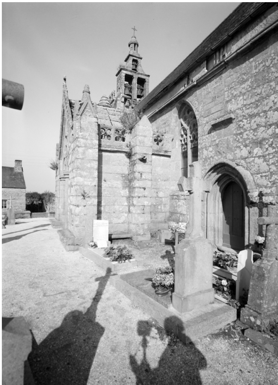
Epaisseur du porche sud
