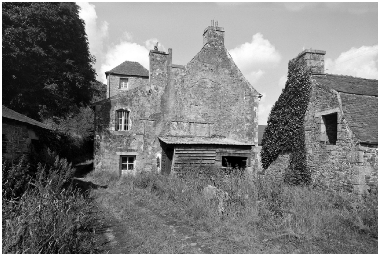
Aile ouest : pignon sud ouest
