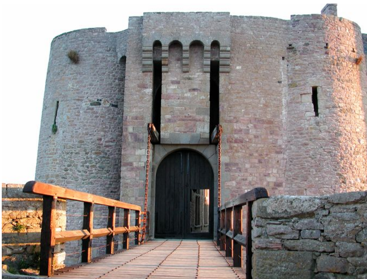
Vue du Fort La Latte
