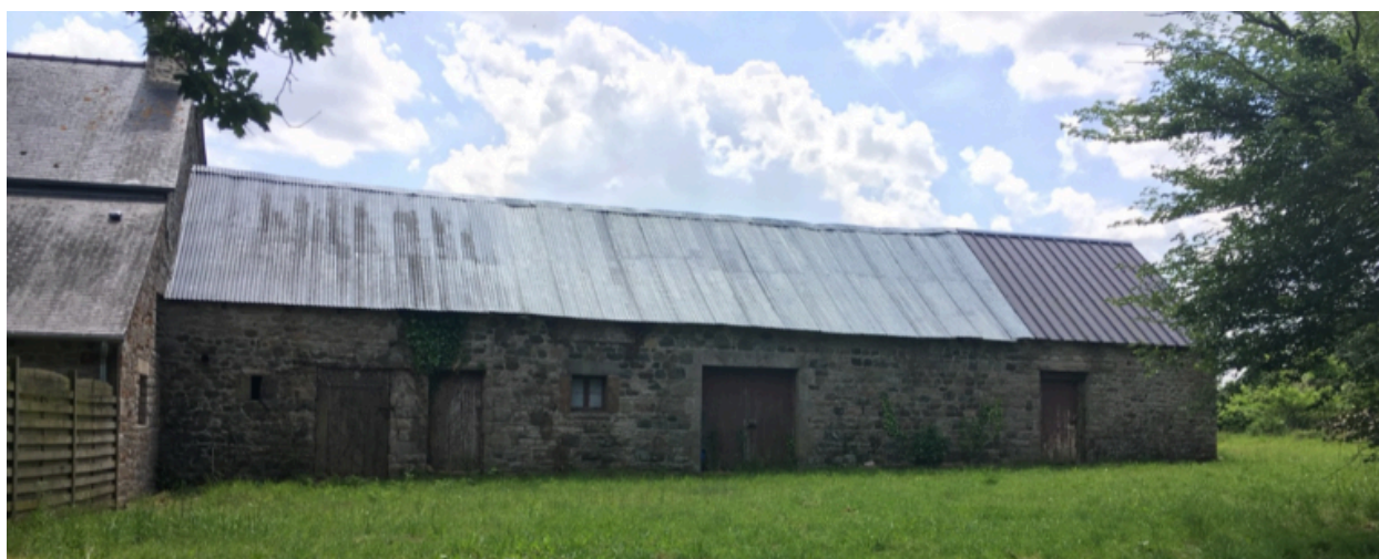
Vue nord des étables de La Moinerie du Portail
