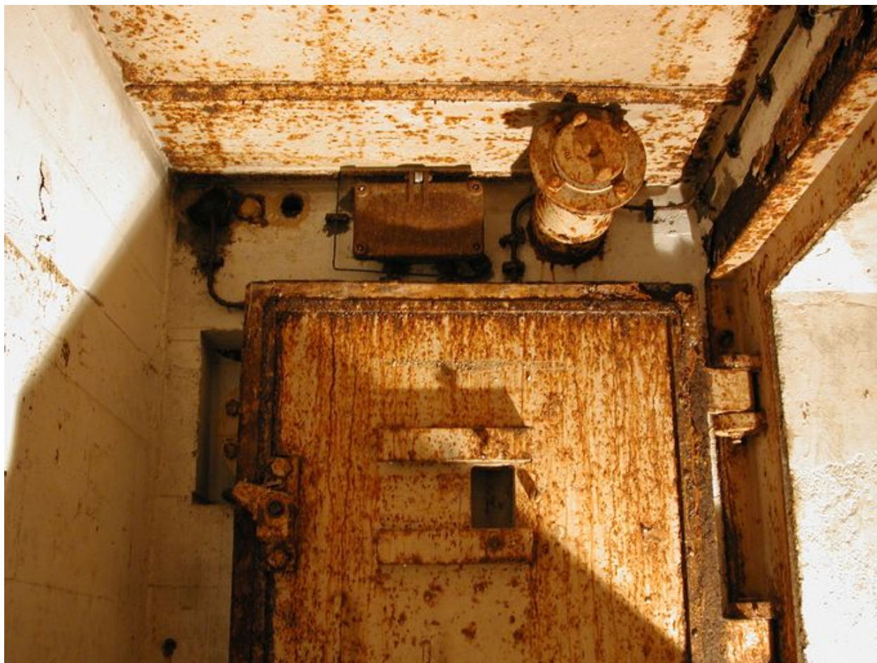
Poste d'observation/petite pièce latérale, détail du vantail supérieur de la porte blindée de type 434P01, boîtier (électrique ?) et récepteur d'antenne (?)
