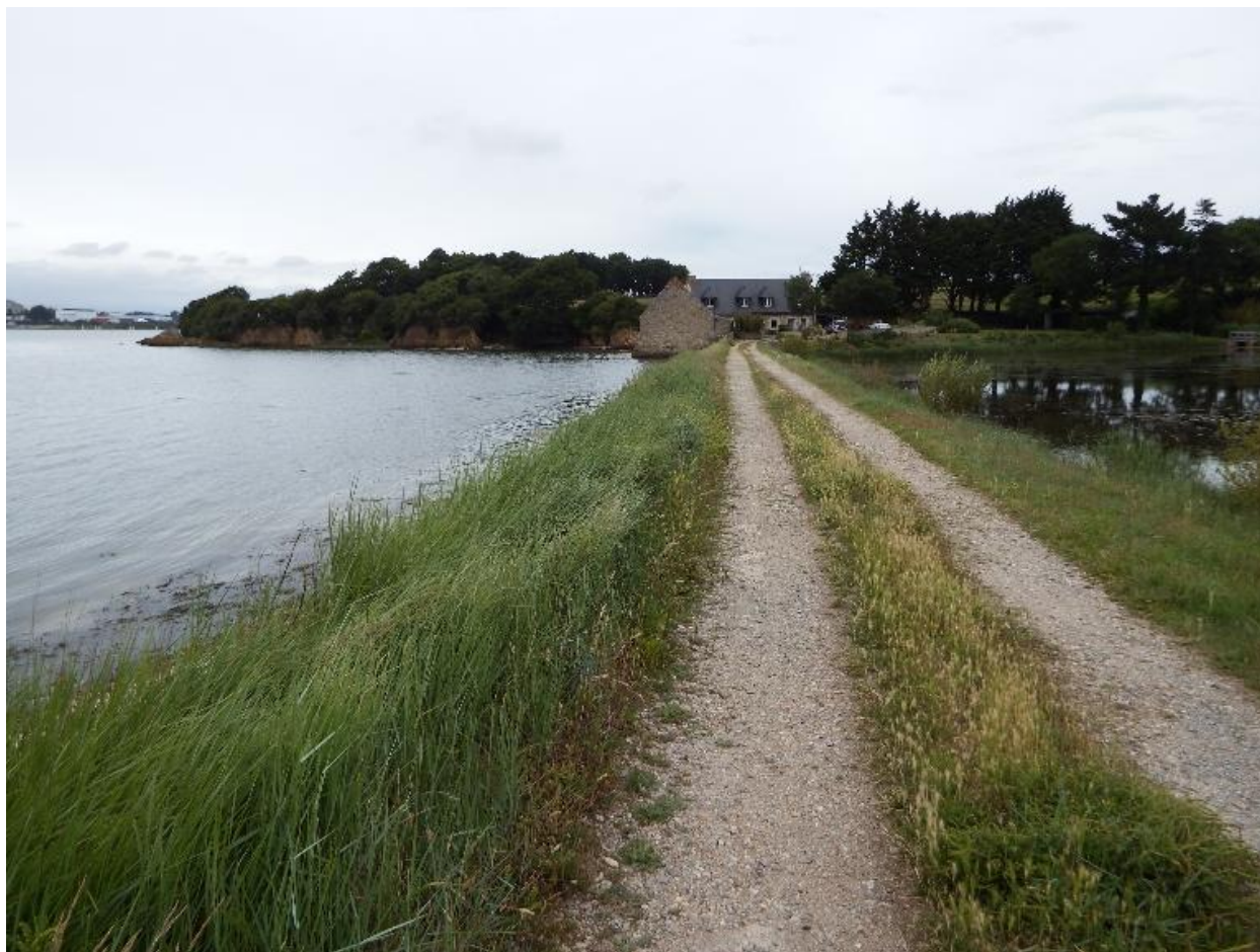
Vue depuis la chaussée
