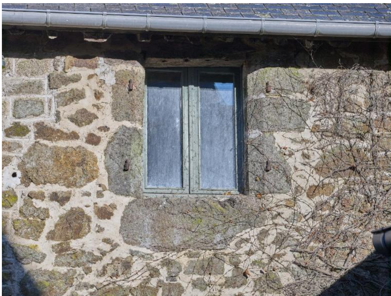
Dépendance fermant la cour au nord. Fenêtre de l'étage
