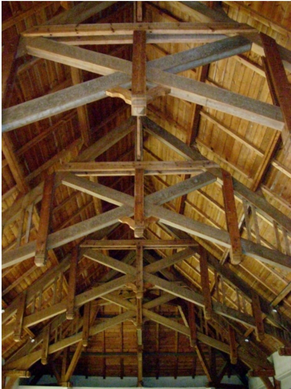
Ploudalmézeau, église de Portsall : détail de la charpente apparente de la nef
