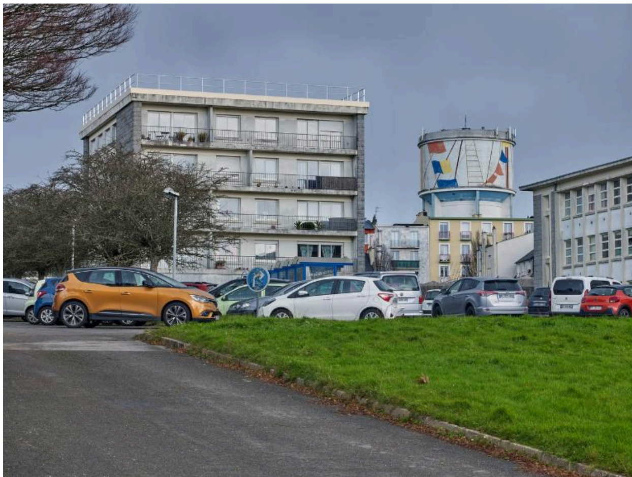
Façade sud de la tour de logements et façade ouest du lycée (vue partielle).
