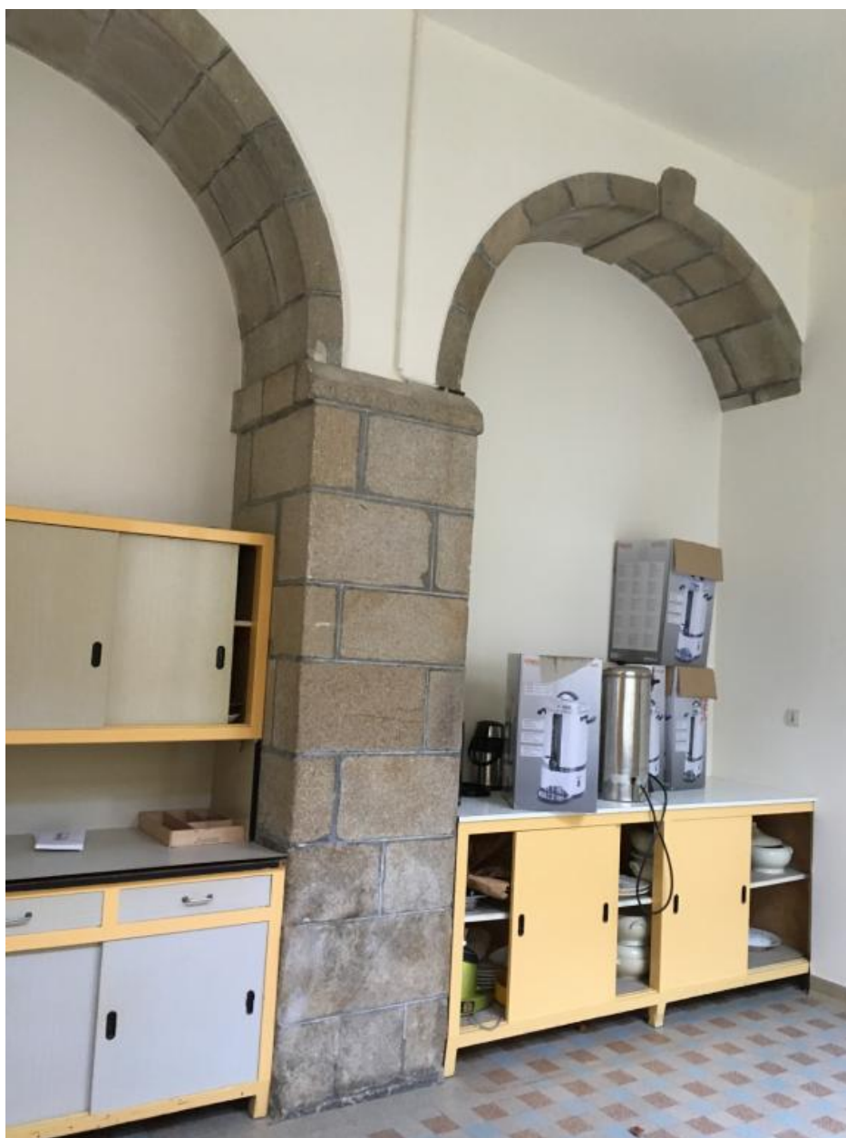
Cloître, galeries (vestiges, 2019)
