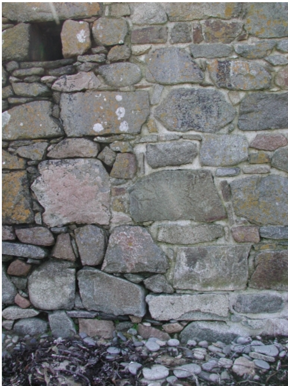
Détail de la maçonnerie du mur de soutènement : partie jointoillée et partie en pierre sèches de moellon
