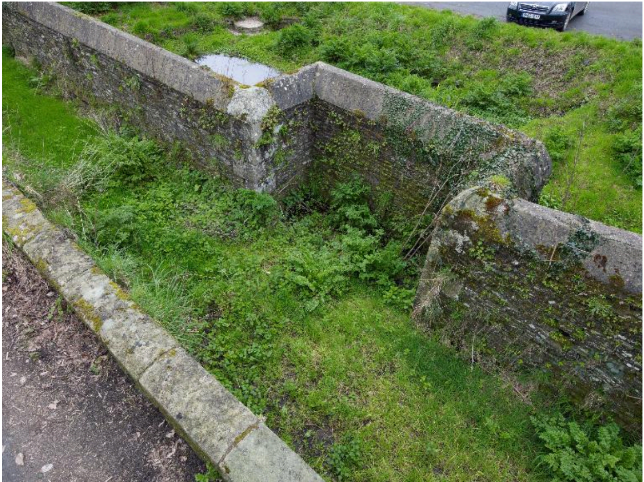
Mur de clôture au sud-ouest du château. Détail de l'encoche pratiquée dans le mur pour abriter la fontaine, accessible depuis la route par une rampe d'accès
