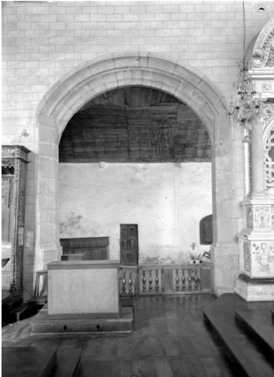
Chapelle nord n°2, vue axiale de l'arcade prise du sud.
