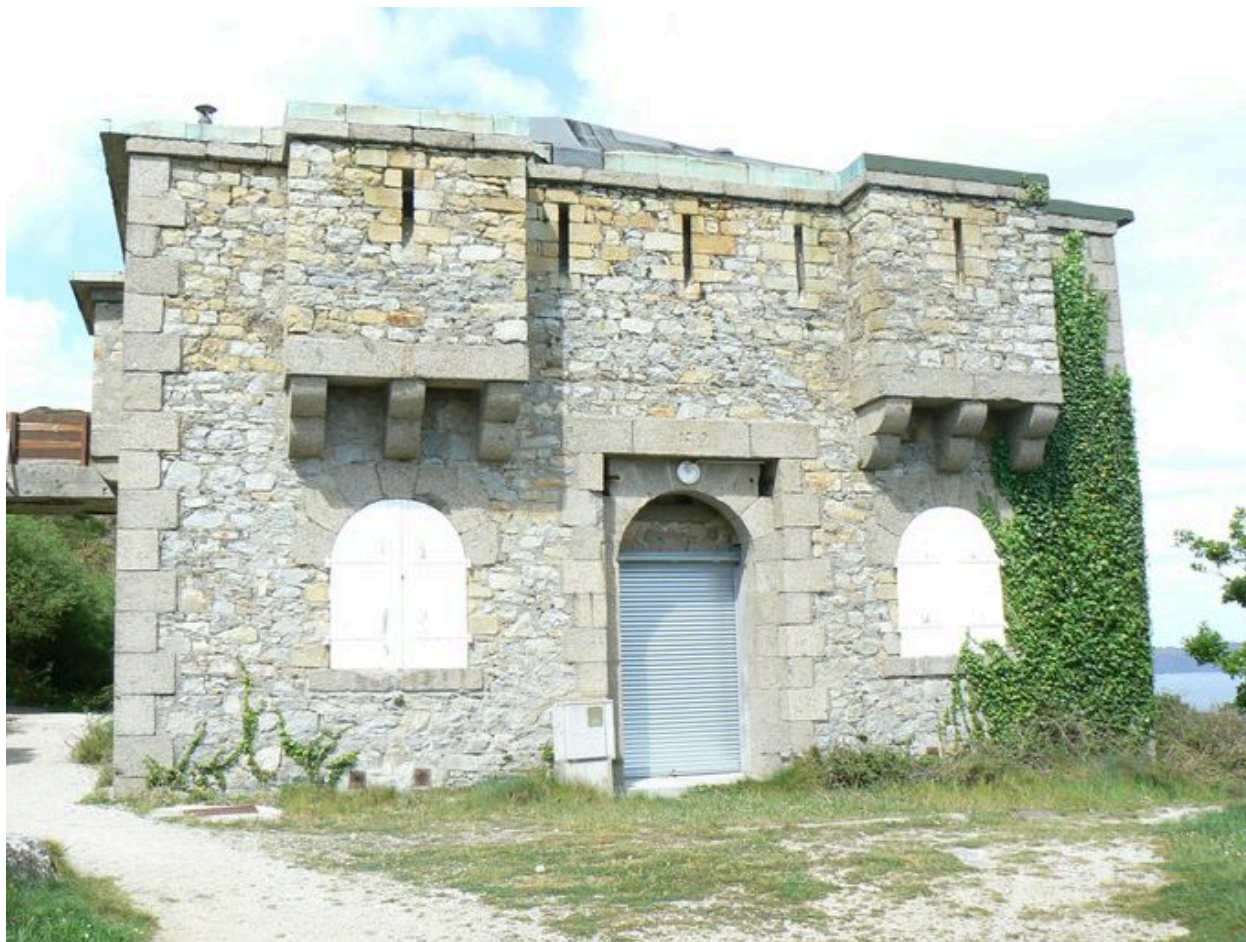
Vue générale du réduit de batterie de côte du Petit Gouin
