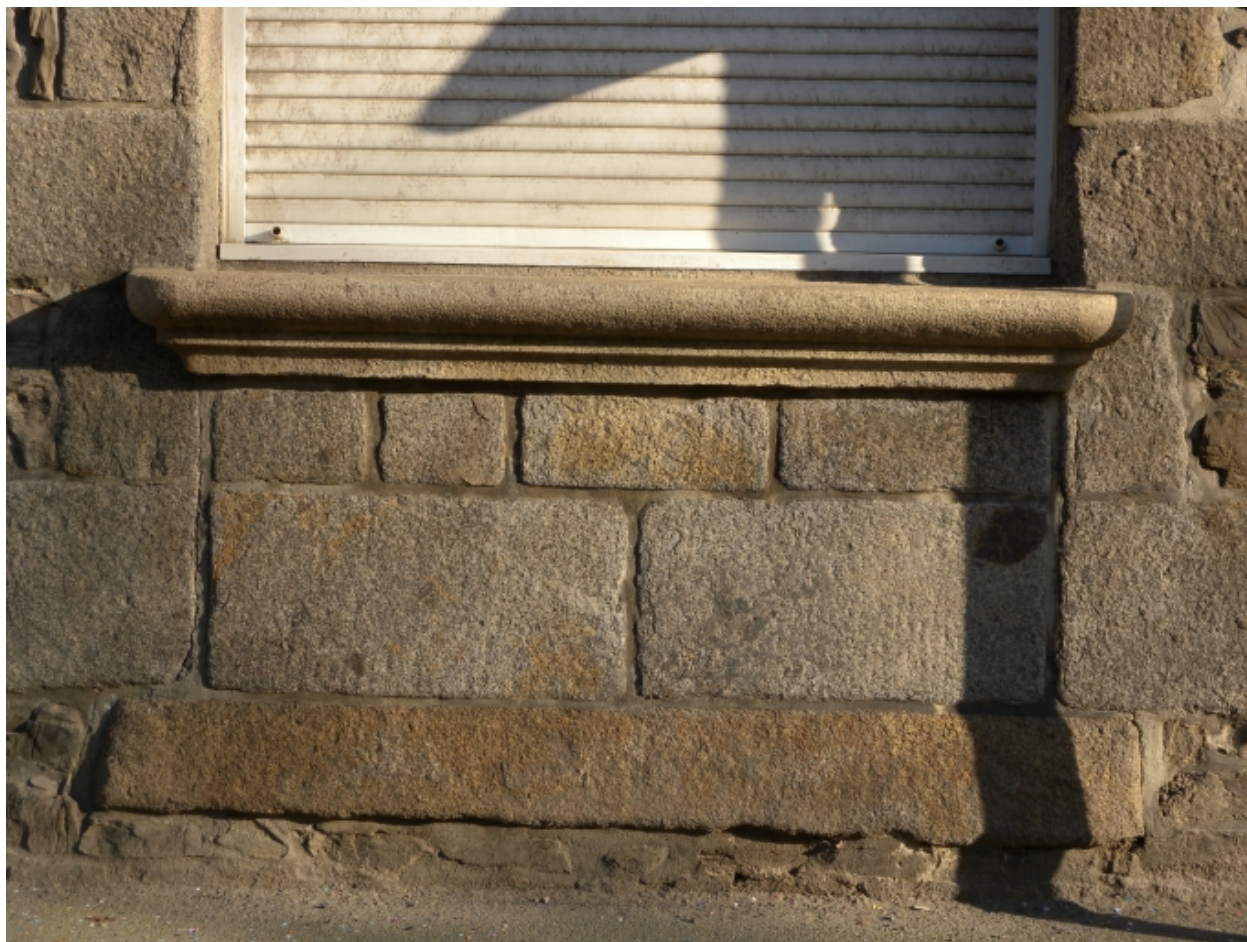
vue de détail du soubassement d'une ouverture avec encorbellement
