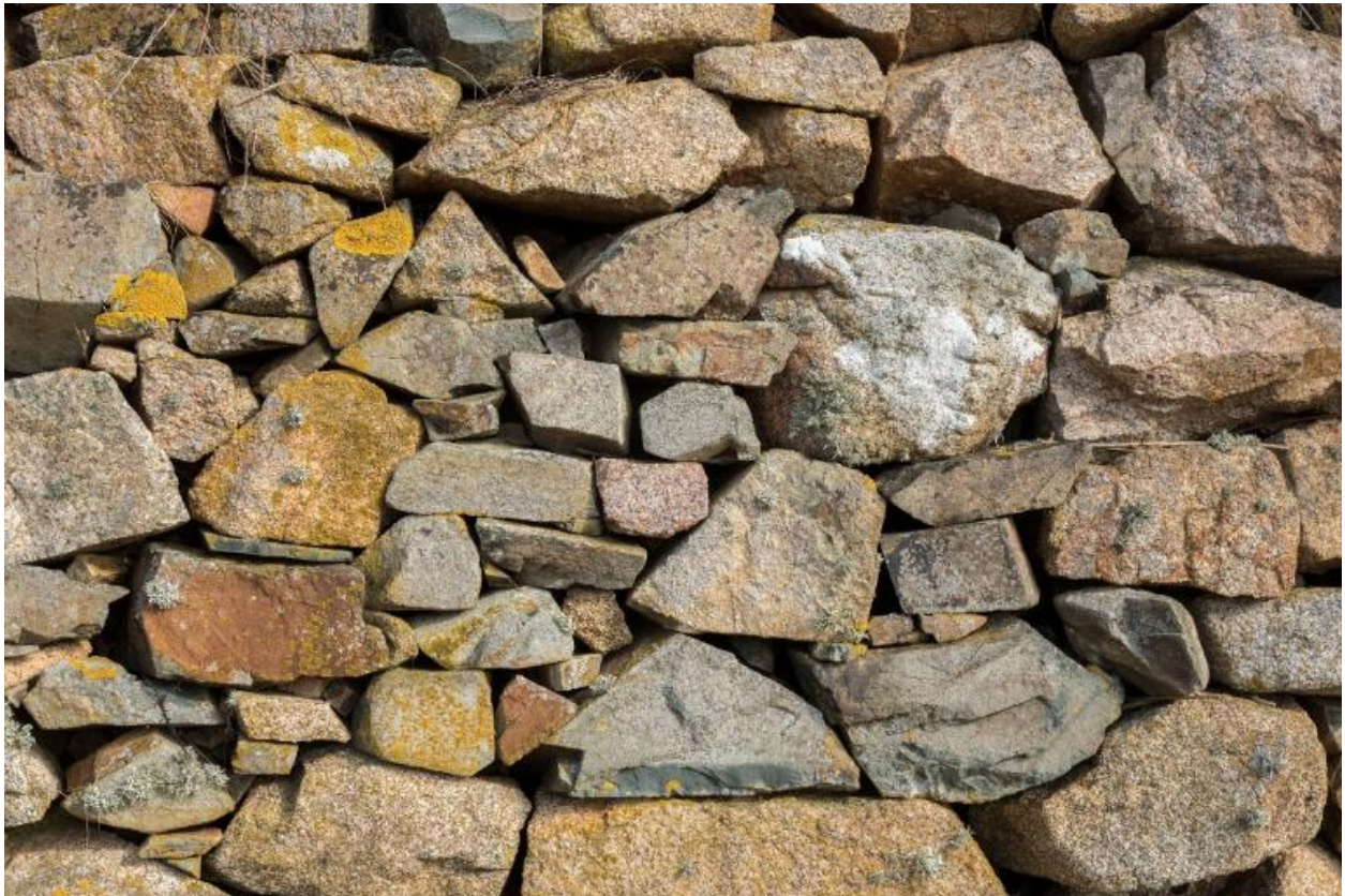
Détail de l'empilement de moellons d'un mur de soutènement de l'anse de Pelinec
