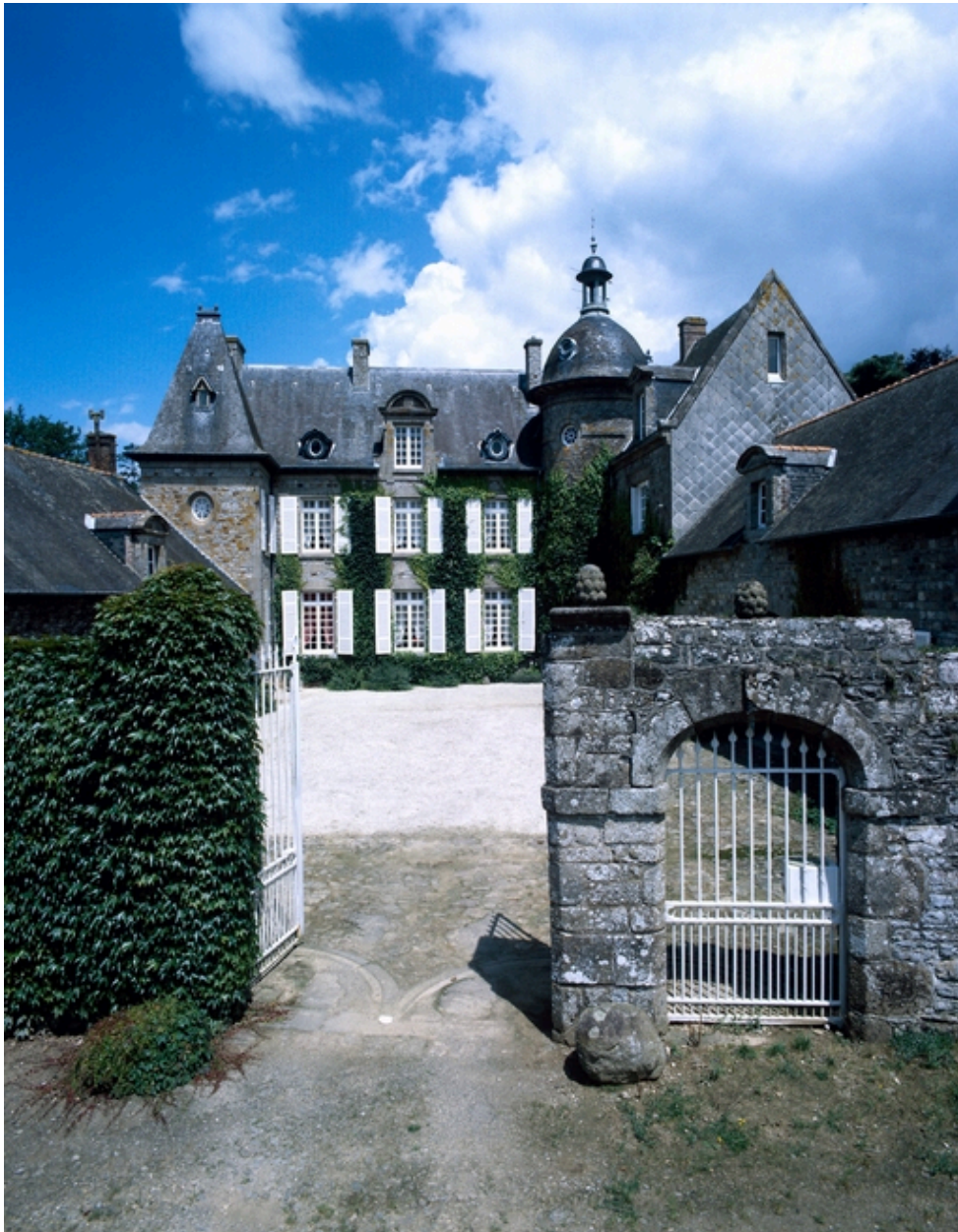
Elévation sud, vue générale sud.
