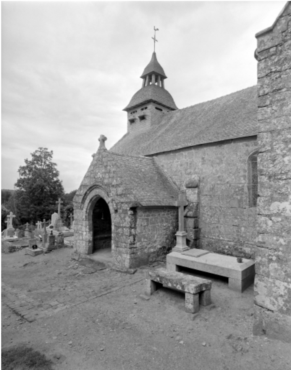
Elévation Sud, porche : vue générale
