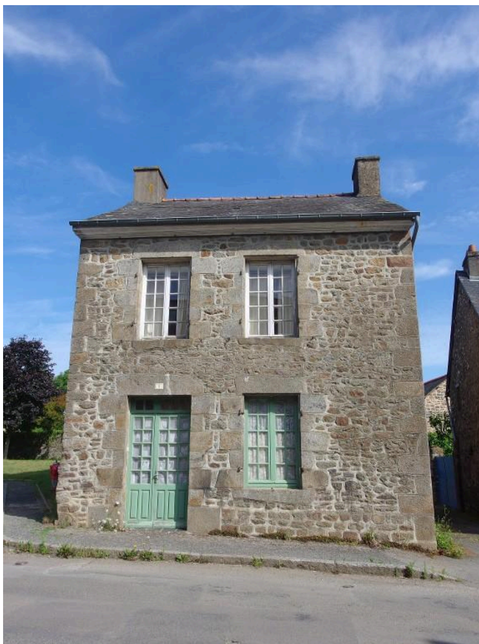
Vue de la façade sud
