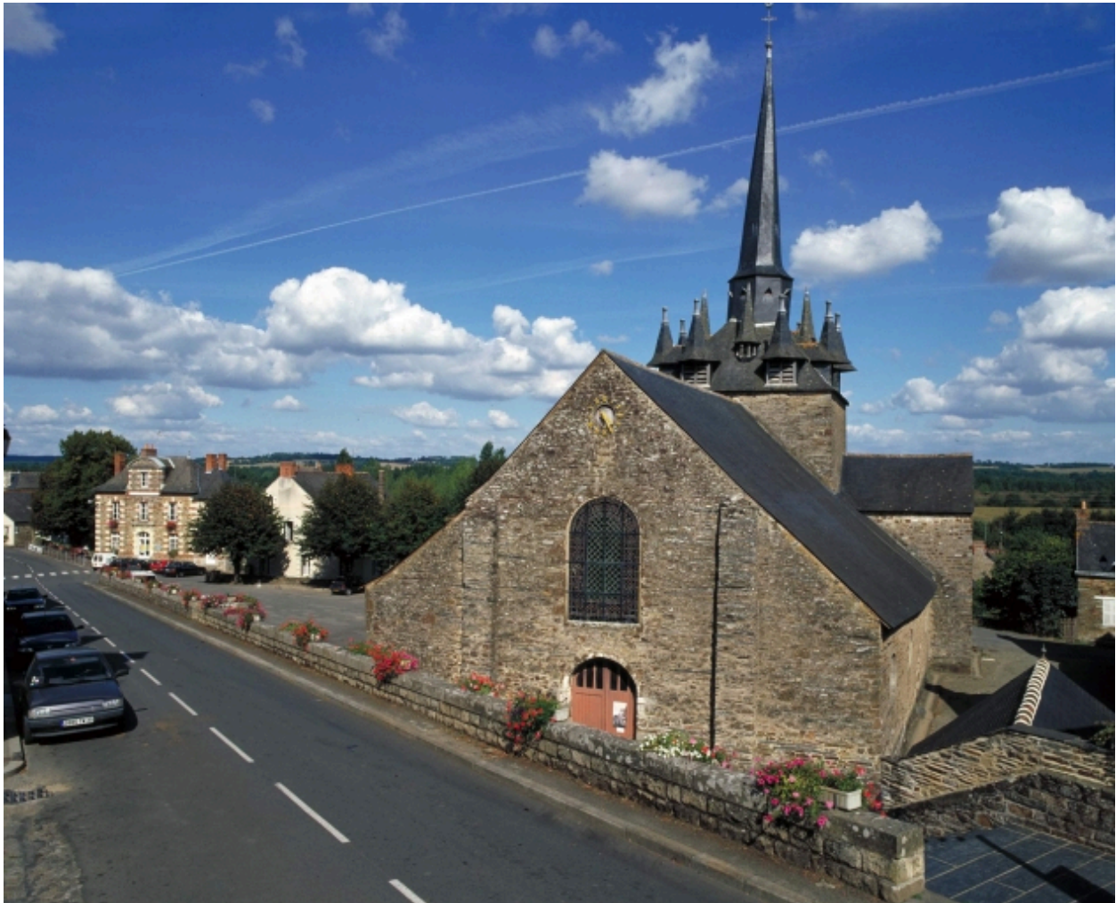
Elévation ouest : vue générale
