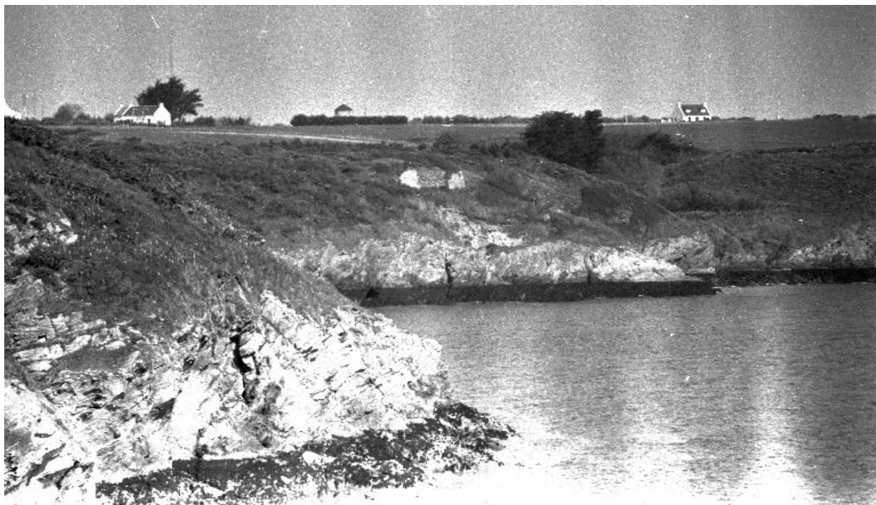
Vue de situation, batterie ruinée
